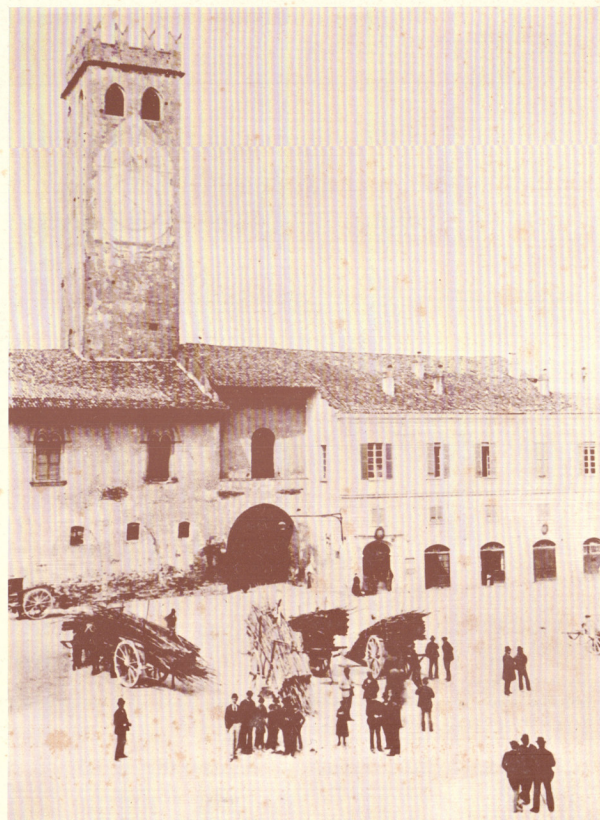
IL CASTELLO DI CASTELNUOVO fu iniziato dai Goti nel V secolo e venne ampliato nei secoli successivi. A ridosso di questo nucleo sorse verso la metà del secolo XIV una costruzione destinata ad essere la Casa del Comune. Nel 1878 il Castello si presentava ridotto in stato deplorabile ed era utilizzato come magazzino. La torre aveva un unico orologio sormontato da un dipinto raffigurante una donna con i giuocconi seni nudi, simbolo della Prosperità. A fianco il palazzo che sino al 1926 sarà sede del Comune. E' giorno di mercato e sulla piazza, siamo all'inizio della primavera, la merce più richiesta sono i pali da vigna. Il restauro, con opere di rafforzamento, ripulitura del loggiato, ricostruzione dell'arengario, rifacimento dei soffitti e scoperta di decorazioni murali risalenti al XVI secolo, viene eseguito negli anni 1934-1935 su progetto dell'ingegner Rigoni.
