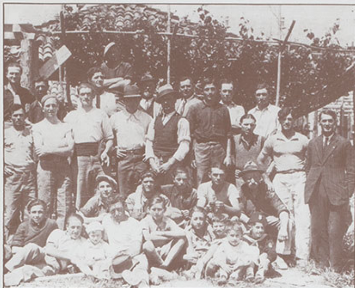
1936 - Muratori e altri addetti alla costruzione della fabbrica del tabacco.
