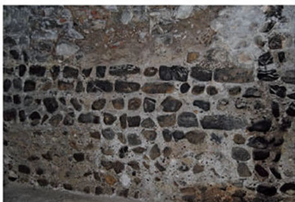
Via Mazzini , sotto la ex segheria Pisa, dinanzi al campanile di San Rocco, un muro assai spesso di sassi sagomati a cubo e durissime malte pietrificate. Ha resistito a molti tentativi di demolizione. A destra particolari del muro di via Mazzini.
