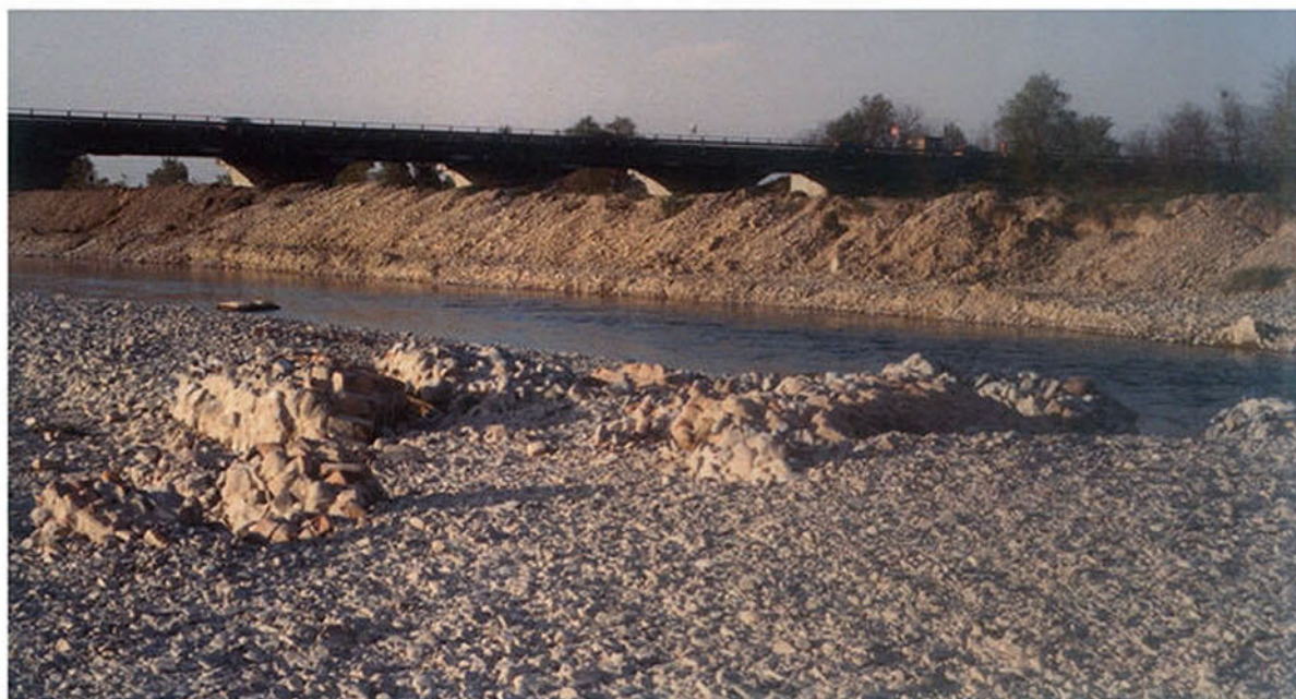
1993. Due ondate di piena e lavori a monte del ponte sull'autostrada mettono a nudo antiche strutture, forse una presa d'acqua per rifornire la zona di Ova e di Goide.
