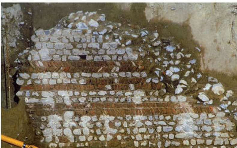
Muratura in file alternate di sassi e mattoni .
