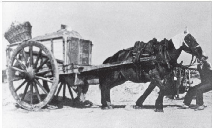
Per tanti anni il mezzo di trasporto più usato fu il trabüchël (detto anche tumbarèl ) a due ruote, ribaltabile, guidato da un carrettiere e trainato da cavalli. In questa antica foto il carrettiere, caricata la sabbia con il badile, aiuta il cavallo a dare lo strattone iniziale.
