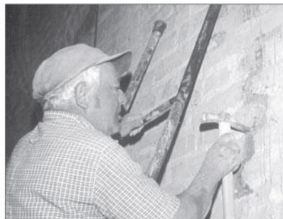
Agostino al lavoro all'interno della torre.
