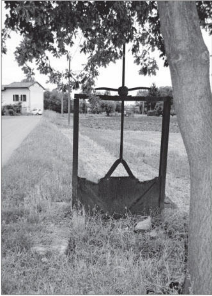
Paratia a vite lungo la roggia del Martinetto in strada dei Cappuccini.
