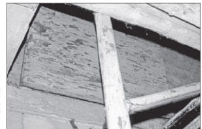
Una ripida scala di legno portava, nelle case più povere, al piano soprastante, a cui si accedeva ribaltando contro la parete una grande botola trapàula .
