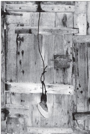
Uno zoccolo di bue batag che con il suo peso teneva chiusa ra purténa del portone - Ra ciäv di legno che rafforzava la struttura dell'arco che sormontava il portone - Un tambiüs (via Mazzini)
