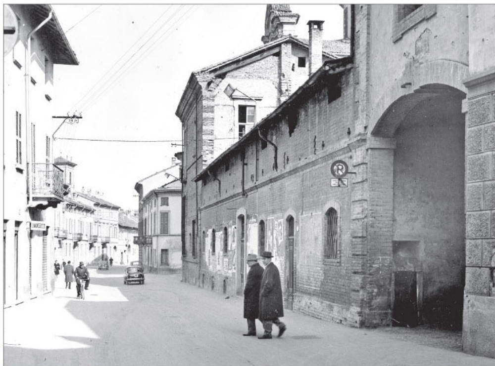
Nei primi anni Cinquanta si interviene con una totale ristrutturazione del collegio di Sant'Ignazio, della chiesa e delle scuole. Nella foto del 1953 Pierangelo Soldini e Pierino Maggi, dopo una visita al cantiere, escono sulla via Roma passando sotto il voltone della Posta. La struttura a destra, adibita a Oratorio, verrà demolita e sostituita con l'attuale palestra delle Elementari.
