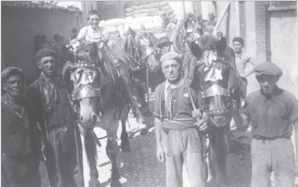
Ditta Sottotetti sementi. Un rimorchio di sacchi di patate con un tiro di quattro cavalli. Se ne occupano, da sinistra, Lazzaro Brasilè , Arona Brüscó e Lunaschi Varşó . Il bambino su un cavallo è Giampietro Sottotetti. Siamo nel 1941.
