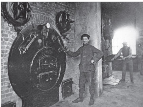
L'imponente caldaia della filanda utilizzata per scaldare l'acqua delle bacinelle.
