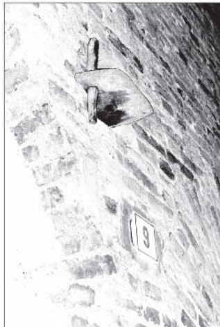
Uno zoccolo di bue batag che con il suo peso teneva chiusa ra purténa del portone - Ra ciäv di legno che rafforzava la struttura dell'arco che sormontava il portone - Un tambiüs (via Mazzini)
