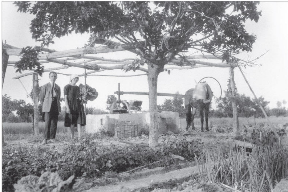
2 giugno 1923, ore 19. I contadini si servono di questo sistema per innaffiare gli orti con l'acqua del pozzo. L'informatore definisce tutto l'insieme la pusa e il dispositivo di innalzamento la nòria : una catena con almeno 20-30 cassette di lamiera sidlèn che portano su l'acqua dal pozzo e la versano, tramite un canaletto a destra, in un fosso che attraversa l'orto. La catena è azionata da un cavallo, con la testa coperta da un panno, che si muove in circolo. Una ragazza con una vérša e il figlio di R.E.
