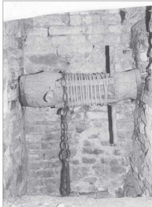
L'interno del pozzo. Buclà , turän , cadnëla e mujëta (moschettone).
