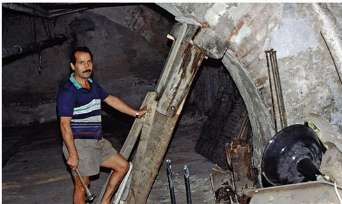
*Dopo il sopralluogo di Carlo Ferrari da Passano nel 1991, si provvede a puntellare le arcate delle cantine, a bloccare l'accesso all'ultimo piano, a porre sotto osservazione le molte crepe.*
