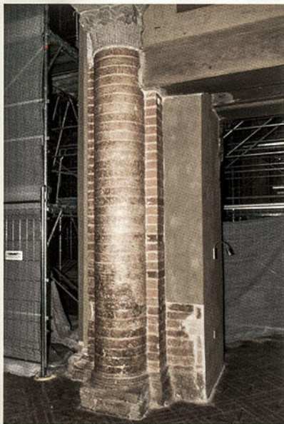
Aspetti dei pilastri del XII secolo di cui sono state poste in evidenza le strutture murarie originarie consentendone così una facile lettura storico-architettonica
