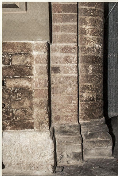
Aspetti dei pilastri del XII secolo di cui sono state poste in evidenza le strutture murarie originarie consentendone così una facile lettura storico-architettonica
