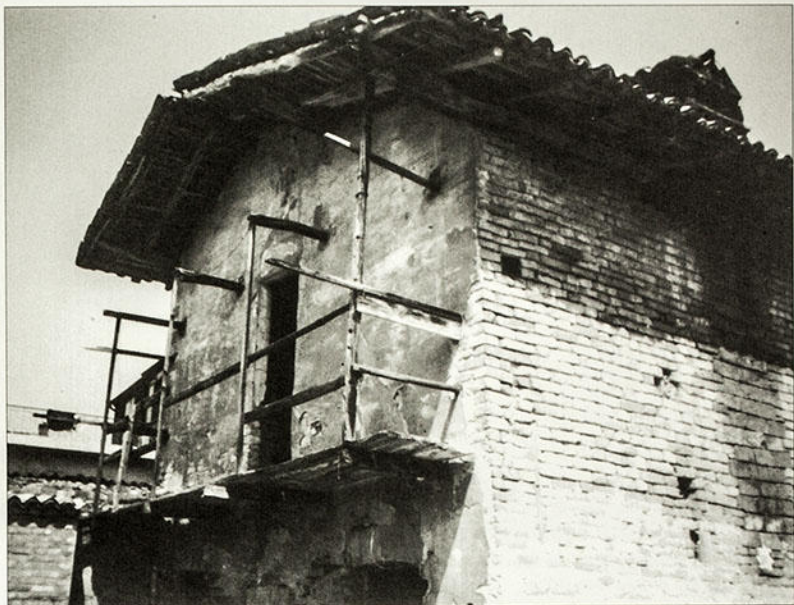
La facciata interna, quella "d'är punti", poco prima dell'avvio dei lavori.
