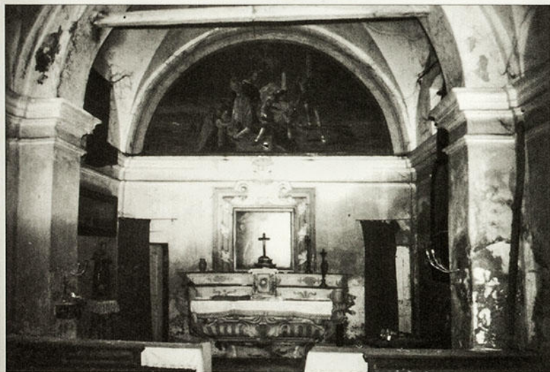
All'interno si forma una ragnatela di crepe e l'intonaco si stacca. C'è ancora chi provvede a tenere pulito l'ambiente, ma è una impresa disperata.
