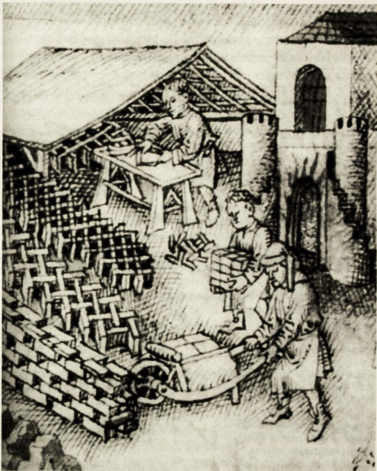
Fabbricanti di mattoni, miniatura, dalla cosiddetta Bibbia di Utrecht, Londra, British Library, ms. add. 38122, f. 78v, XV sec. In questa miniatura sono documentate tutte le fasi della produzione dei mattoni che, una volta cotti, vengono disposti con cura e attenzione in file ordinate e ben areate. Un artigiano utilizza una carriola, attrezzo di invenzione medievale, già conosciuto nel XIII sec.
