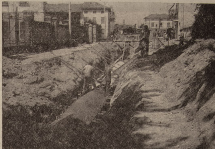
Una visione dei grandiosi lavori in via Mazzini (Viale della Rimembranza). Tra qualche giorno sarà possibile l'accesso al mercato ortofruttilicolo ed alle frazioni dirittamente senza la lunga deviazione per Paradiso.
