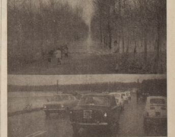
In alto: il tronco stradale provinciale come appariva, durante la piena del Po, prima della costruzione del Ponte. In basso: come appare ora la Statale per la Lomellina con il nuovo Ponte
