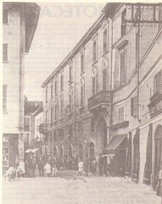
Il bellissimo palazzo Costa, all'inizio di via Cavour, abbattuto intorno al 1960. Dapprima il progetto prevedeva la costruzione di un edificio a nove piani con un tetto a punta, da casa alpina. Un autentico orrore, evitato solo in parte. Nella foto una domenica di 80 anni fa. È da poco terminata la messa (il grosso orologio appeso dinanzi all'orologeria Spinola indica le 12,20). A sinistra, accanto alla vetrina di Moggi, sono in vendita, posato su alcune sedie, i «brasadè». Gli eleganti, con paglietta e gilè, visto il fotografo, si sono messi in posa; ma qualcuno, stanco per l'attesa, si è seduto utilizzando le sedie della venditrice di ciambelle e la panca davanti alla tabaccheria. La scena è dominata dalla maestosità del frontale del palazzo Costa, con le ampie finestre del piano superiore, le finestrelle dei mezzanini, il magnifico portale in pietra e la successione di negozi ad arco.
