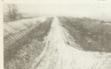
La ghiaia viene portata al centro dello scolmatore per facilitare il transito degli automezzi
